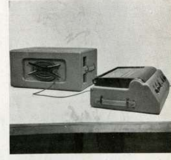
13. Centrale di «impianto radioteleco per appartamento», costituita da un ricevitore italiano, sistemato in un tavolo per la stanza di soggiorno. Il piano del tavolino sostiene riproduttore e radiorecettore che sono disposti nel miglior modo onde evitare risonanze e facilitare il comodo uso.
